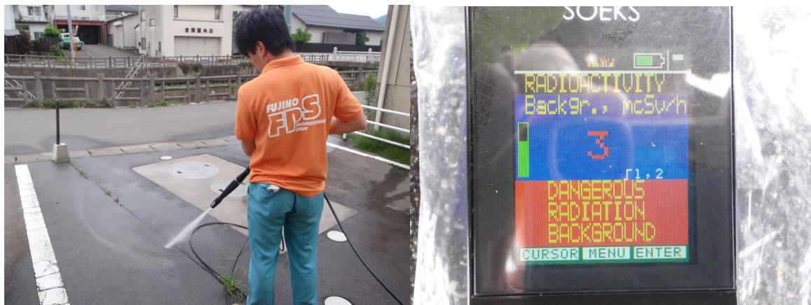
■ 高圧洗浄2回目（洗浄剤洗浄） 【洗浄後計測値：1.66 マイクロシーベルト】
